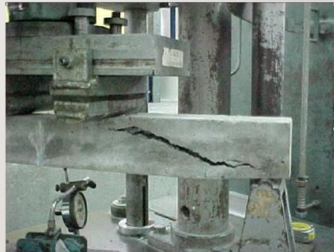
Falla por tensión diagonal de vigas
